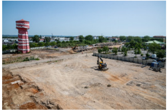
Chantier de l'esplanade TASE, Métropole de Lyon
