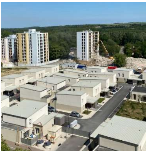
Démolition d'un immeuble dans le quartier du Hamois - © Le Foyer Rémois
