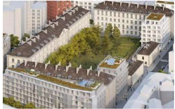
La caserne de Reuilly vue du ciel - © TUVERRAS
