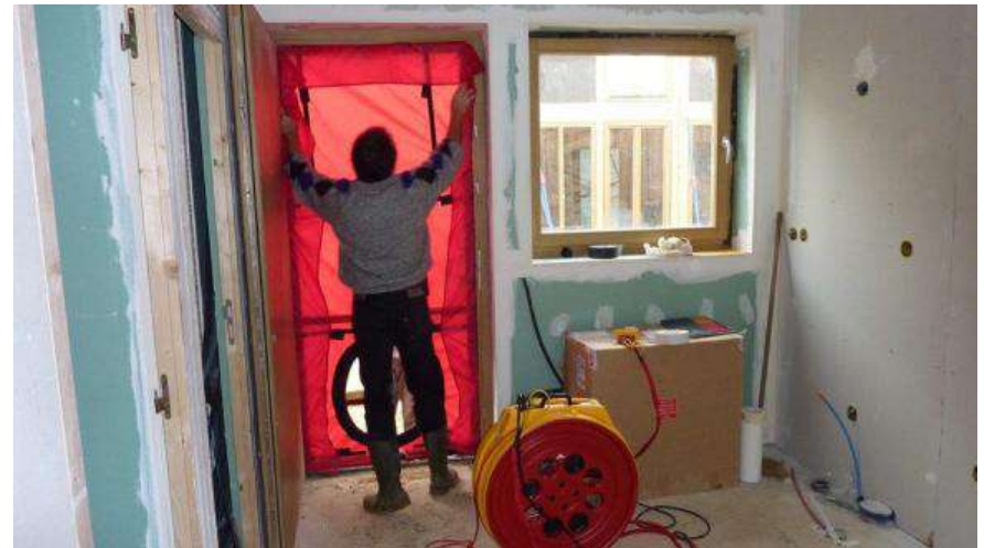
Test d'étanchéité à l'air
