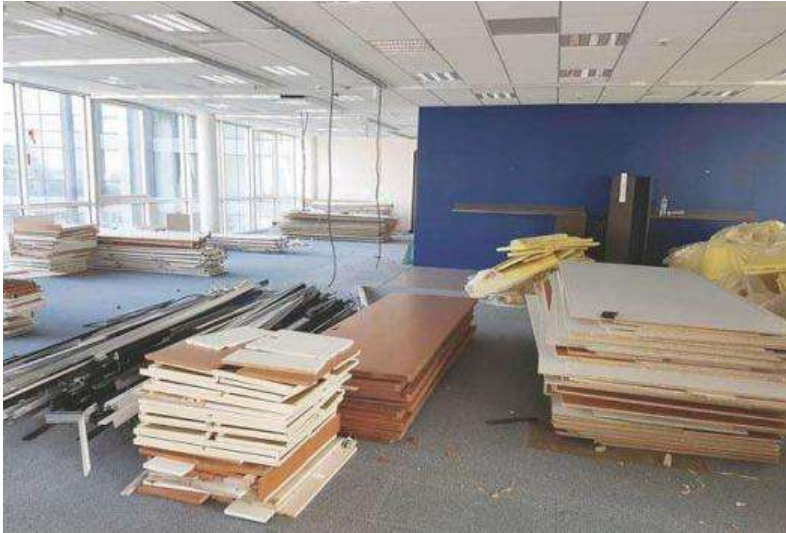
Déconstruction avec dépose sélective
