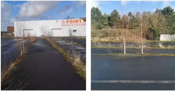
Etat existant de la friche
